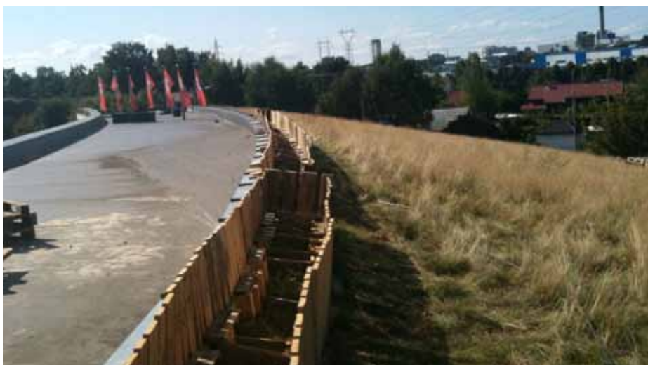
13: Bygging av vekstkasser på ALNA-taket. Foto: Maiken McCormick.
