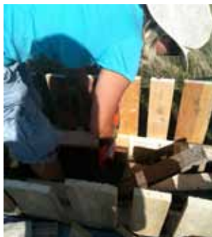
6: Lokal samfunnsbasert takhage i Oslo. MAJOBOS takhage på ALNA senteret. Bygging av vekstkasser av paller. Foto: Maiken McCormick .
